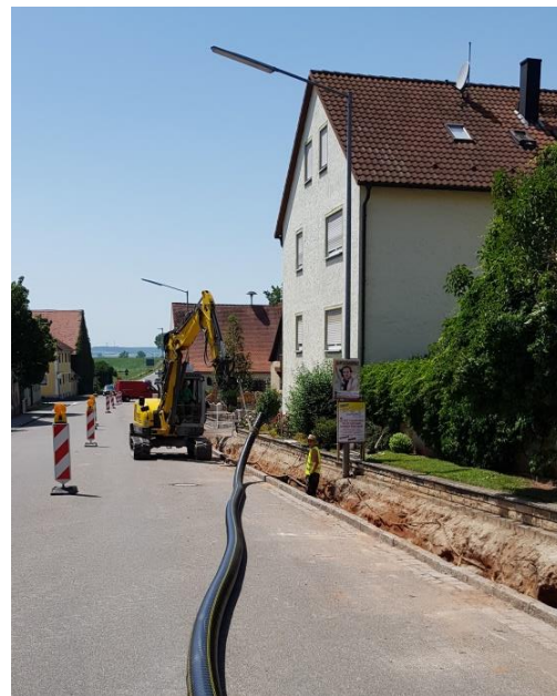
Verlegung im offenen Graben
