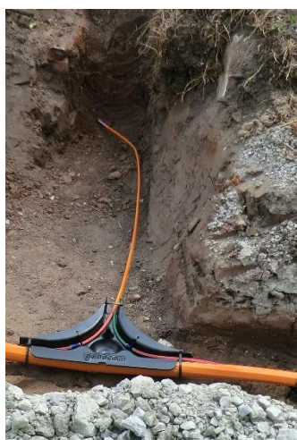
Mikrorohr Netzanschluss 2x7mm
